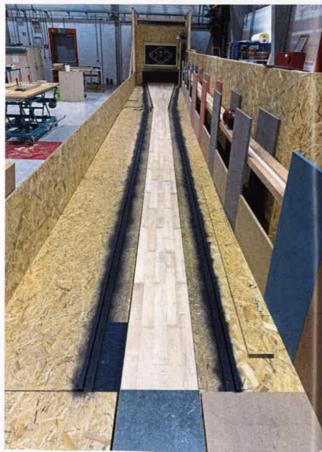
Während die Elektronik und Mechanik wiederverwertet wurde und aus dem Café „Beim Karin“ in Leudelingen stammt, sind die eigentliche Piste sowie Unterbau und Verkleidung neu.
